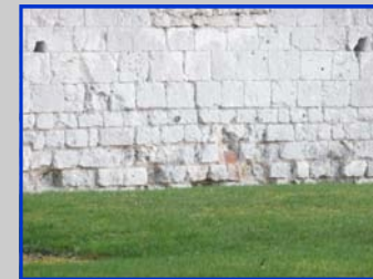
Les soubassements sont fortement détériorés par la stagnation des eaux de pluie...
