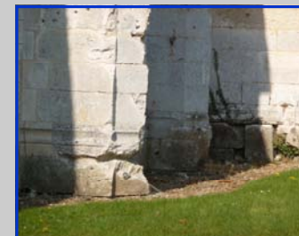
Les soubassements sont fortement détériorés par la stagnation des eaux de pluie...
